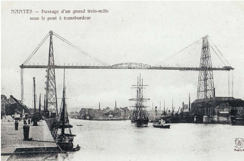
Le pont transbordeur, construit en 1903 sur un des bras de la Loire, à Nantes, permettait le passage des voiliers à fort tirant d'air, comme le Belem .
